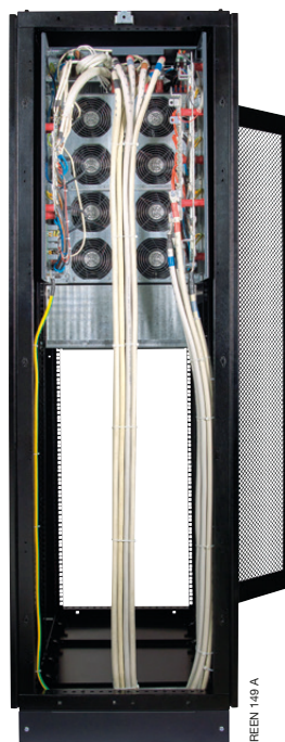
Widok z tyłu (przed założeniem tylnej pokrywy ochronnej). Elastyczne zarządzanie przewodami ułatwia wykonywanie połączeń oraz porządkowanie kabli.
